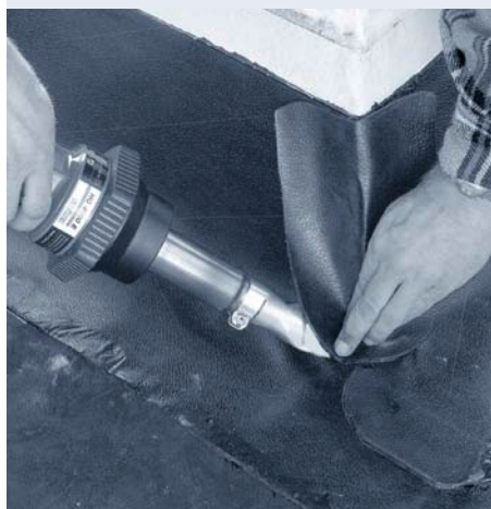
Soudure de bâche
