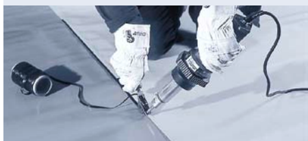
Soudage de joints
