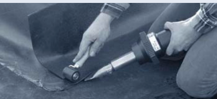
Soudage des cartons bitumés
