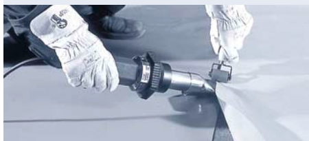
Soudage de bâches
